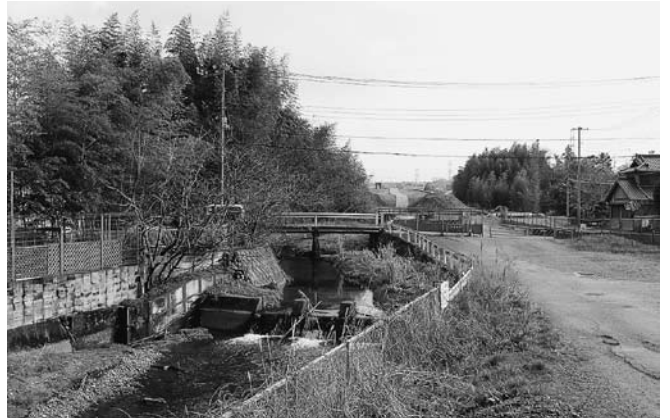
長瀬地内「中橋」附近
