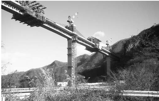
着々と進むハツ場ダムの補償工事
