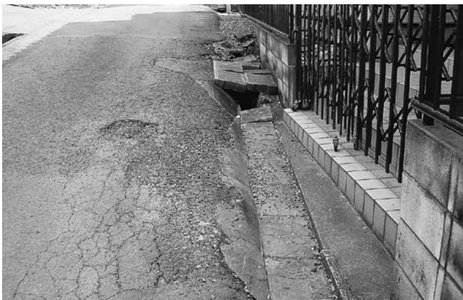
急げ! 蓋なし狭小側溝の改修 (整備率 20%の学園台団地)
