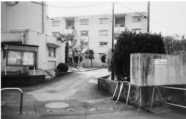
更地にして公売予定の雇用促進住宅
