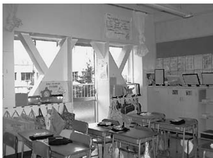
川角小学校舎の耐震補強工事
