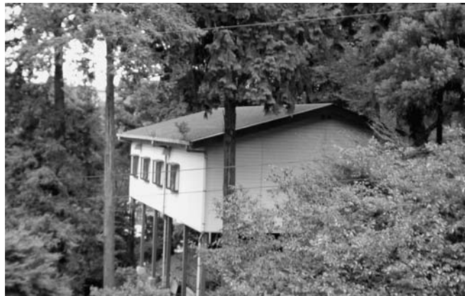
早期の耐震診断、耐震工事が望まれる山根荘大広間
