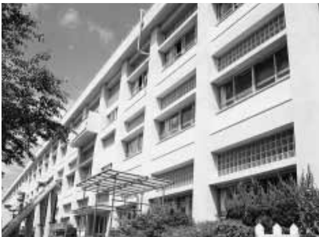
校舎耐震補強工事が行われる毛呂山小学校
