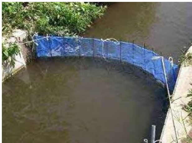
流出防止を目的とした網の設置例
