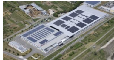
工場の屋根置き太陽光発電
