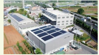
千両リサイクルプラント(愛知県豊川市)
