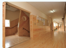
都幾川中学校校舎（内装木質化）
