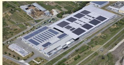
工場の屋根置き太陽光発電
